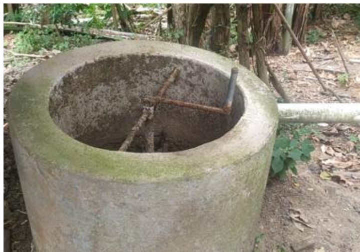
Gambar 7. Tempat Pengadukan Kotoran Sapi
