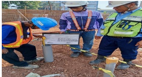
Gambar 4. Proses Pengujian Kebocoran Setelah Optimasi
