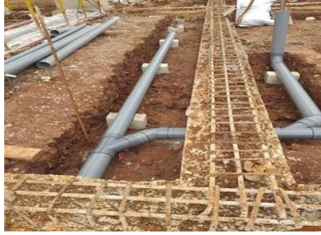
Gambar 2. Proses Penyambungan Pipa Peralon di Lapangan
