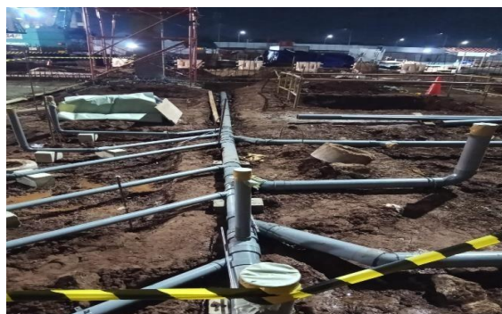
Gambar 3. Kondisi Permukaan Pipa Sebelum Penyambungan
