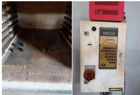
Gambar 5. Proses Pengeringan Menggunakan Heat Treatment
