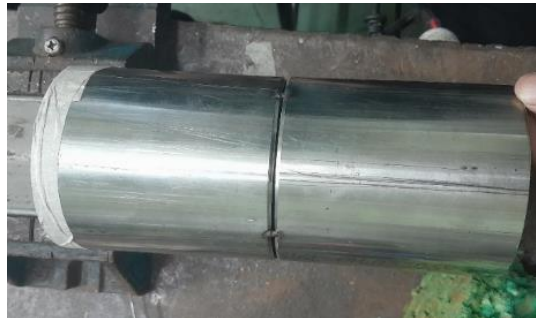
Gambar 4. Las Ikat ( tack-weld )
