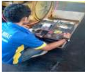
Gambar 5. Pengecekan pada battery
