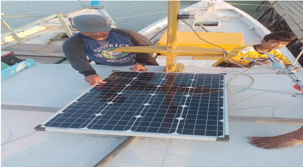
Gambar 3. Pengukuran Tegangan Keluaran Pada Solar Cell 100 wp
