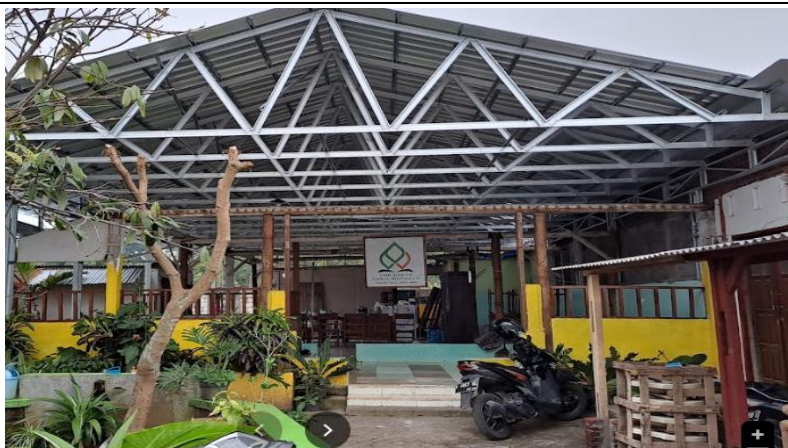
Gambar 3. Salah Satu tempat di Pondok Darul Muttaqin Batu Yang Bangunannya Menggunakan Galvalum
