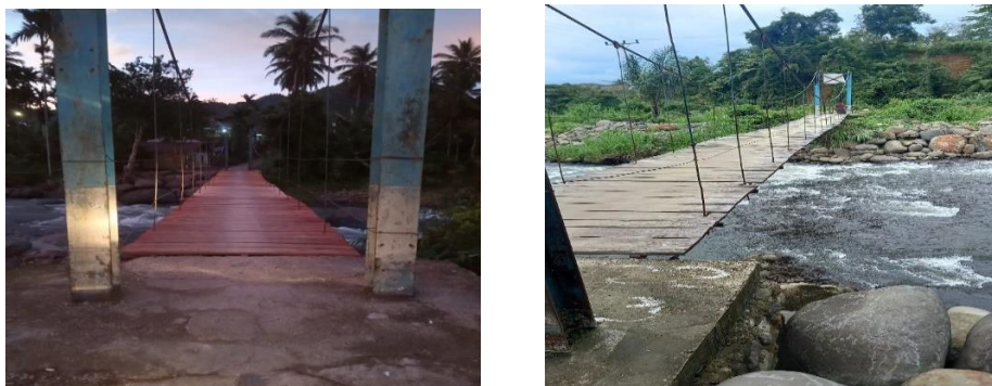
Gambar 4. Hasil Jembatan Gantung Yang Sudah Selesai
