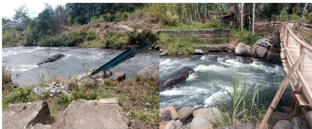
Gambar 1. a. Kondisi Jembatan Setelah Terputus, b. Jembatan Gantung Sementara
